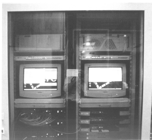
Un pannello trasparente impedisce all'operatore di toccare i tasti del master control
